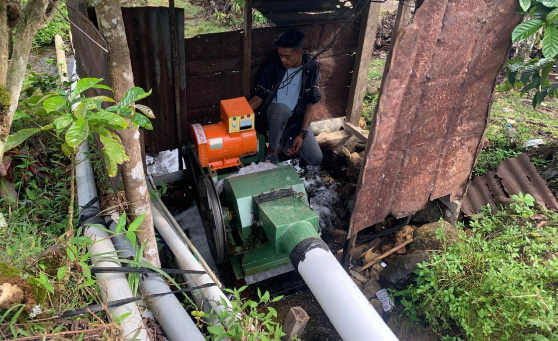
Kampung Rantau Dedap, Desa Segamit, Kecamatan Semende Darat Tengah, Kabupaten Muara Enim, Sumatera Selatan berada di ring 1 Pembangkit listrik Geothermal PT Supreme Energi. Kampung ini belum teraliri listrik. Warga menggunakan turbin yang digerakkan oleh air yang mengalir dari mata air pengunungan di Bukit Barisan untuk menghasilkan listrik.
